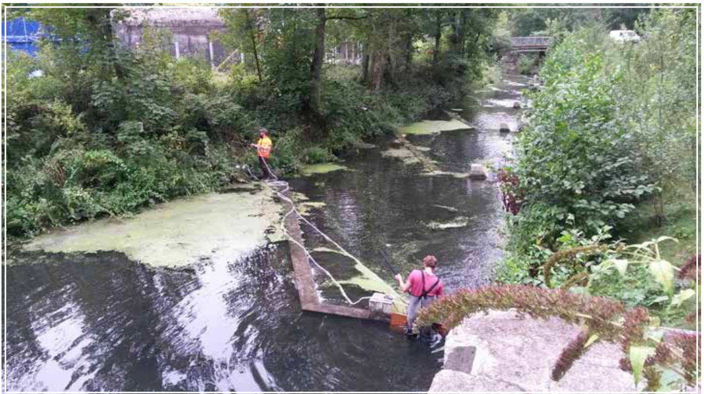
Figure 1 : Pose des antennes sur la passe de la Traitore
